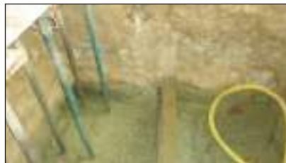
Se descubrió un manantial en el sotano de 350 litros/hora. Se han utilizado más de 1700 puntales simultáneamente
