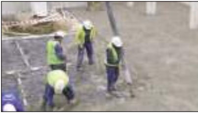
25.500 kg de acero en el hormigón armado. Se han utilizado en total 420 m3 de hormigón
