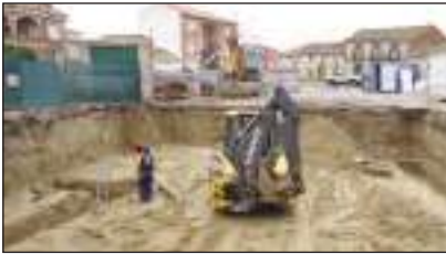
Se han excavado 1.160 m3 de tierra
